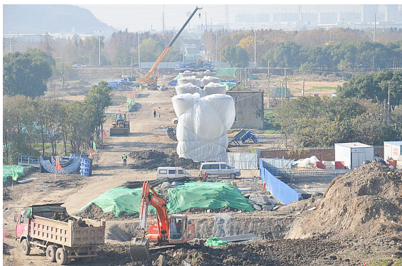
△澄江街道段建设进度实拍
