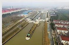
锡澄运河新夏港船闸
