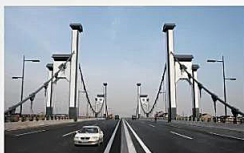
芙蓉大道张家桥
