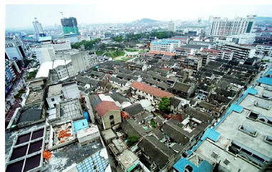
△拆迁前的后火叉巷。火叉巷,曾是救火水龙所在地,为江阴古城消防重地
