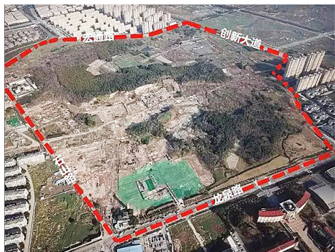
△建设中的蟠龙山公园
