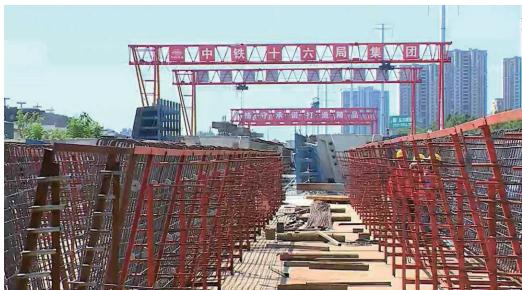
双向六车道，设计速度为每小时80公里。目前，起点位于澄杨路北侧、全长2.417公里的云亭高架桥已拔地而起、初具雏形。“云亭高架桥已架设完成1.8公里，预计年底可实现主线基本贯通。”中铁十六局长山大道快速化改造工程项目党支部副书记樊克辉告诉发布君。
